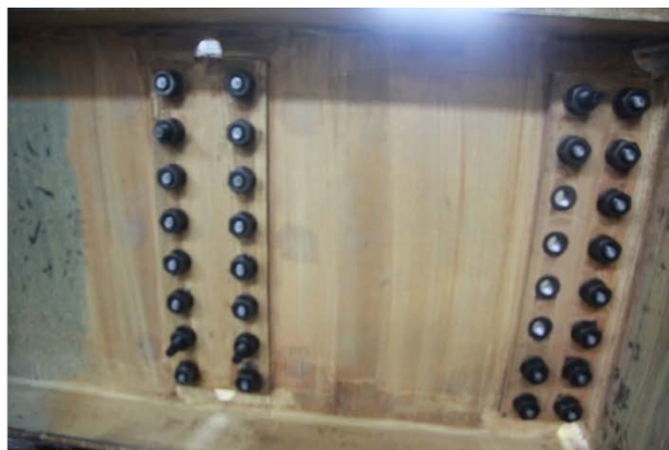
圖 2 梁腹開孔後增設摩阻型螺栓接合
